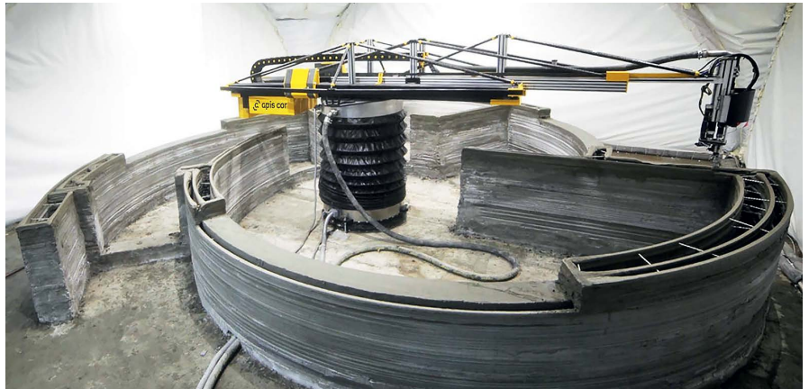
Рис. 7. Роботизированный комплекс, оснащенный печатной головкой и манипулятором для укладки элементов дома (компания СССР, США)
