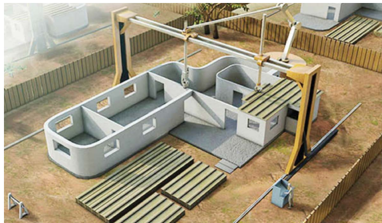
Рис. 7. Роботизированный комплекс, оснащенный печатной головкой и манипулятором для укладки элементов дома (компания СССР, США)
