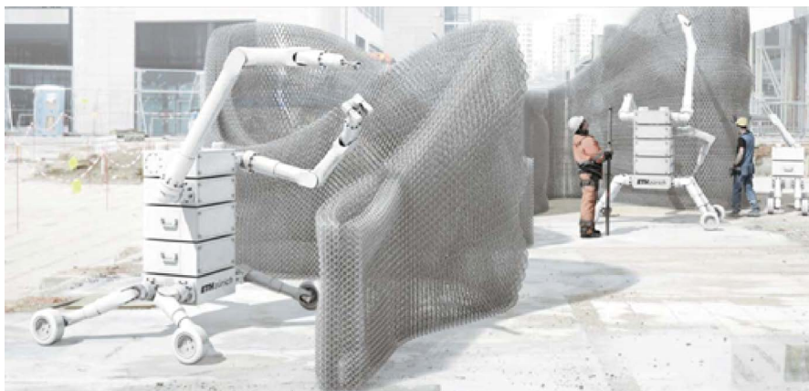
Рис. 15. Использование роботов для построения сложных пространственных структур
